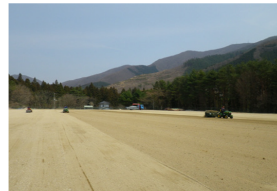
グラウンド全体整備完了
