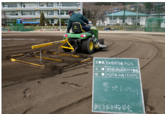
整地作業(レベラー)
