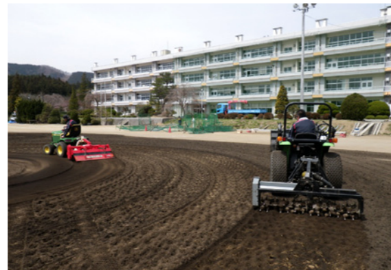
掘り起しと攪拌作業
