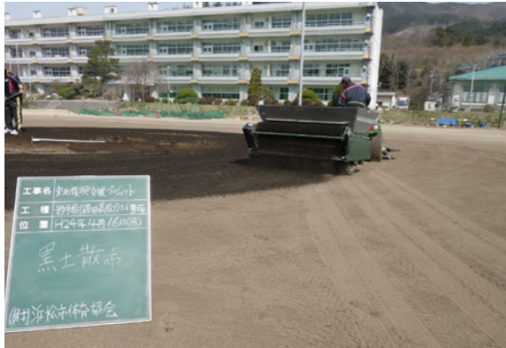
黒土散布(新しい土を内野全体へ散布)
