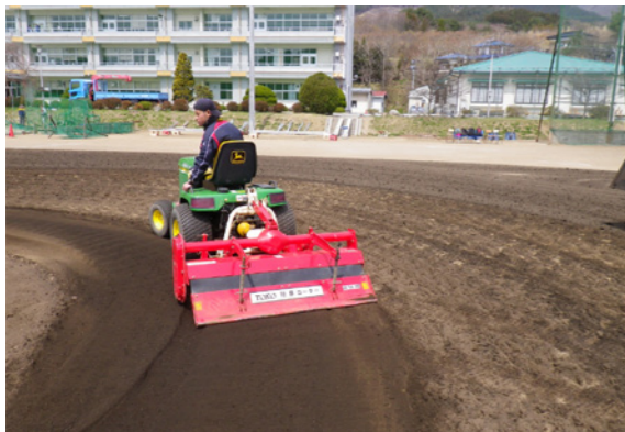
攪拌作業(土をさらに細かく混ぜる)
