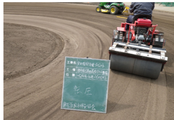
転圧作業(コートローラー)
